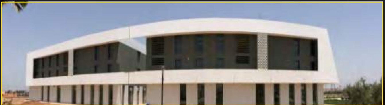
FAÇADE OUEST DU BÂTIMENT DE L'ADMINISTRATION
