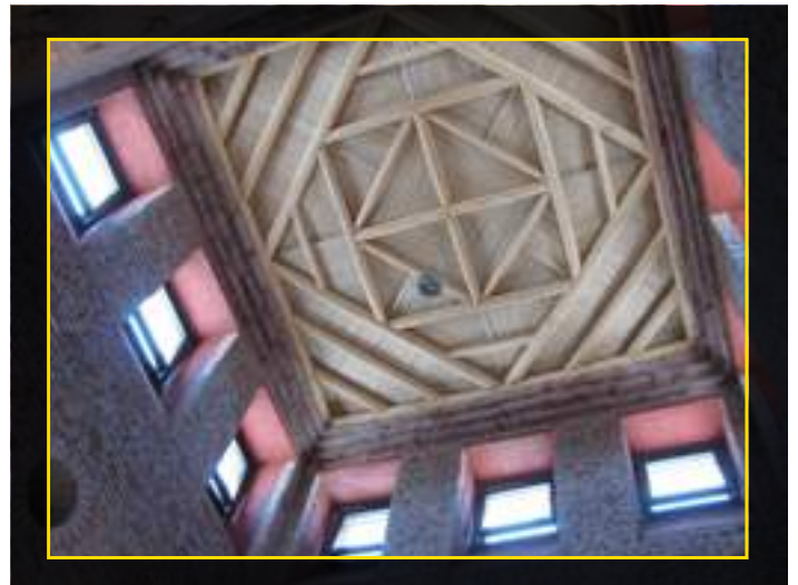
Ouvertures adaptées pour contrôler les surchauffes : en été, ces pièces étant exposées à un rayonnement solaire intense.
