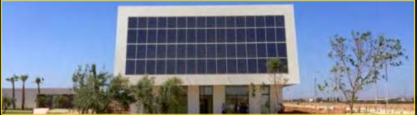
FAÇADE SUD DU BÂTIMENT DE L'ADMINISTRATION
