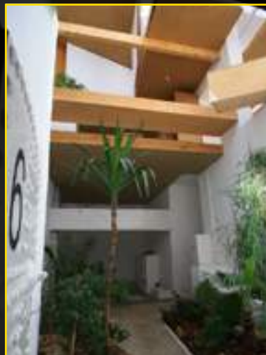
ENTRÉE ET VUE SUR TRAITEMENT DES EAUX
